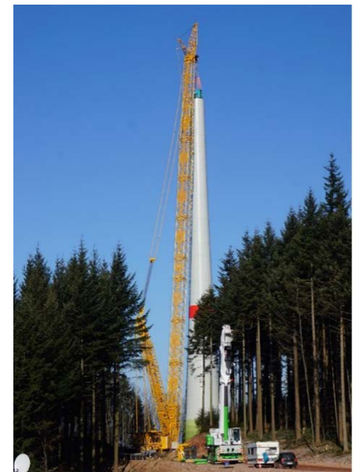
Bild 3: Kran mit Kranausleger beim Bau einer Enercon E-115 Windenergieanlage (Bild: Rolf Pfeifer)
